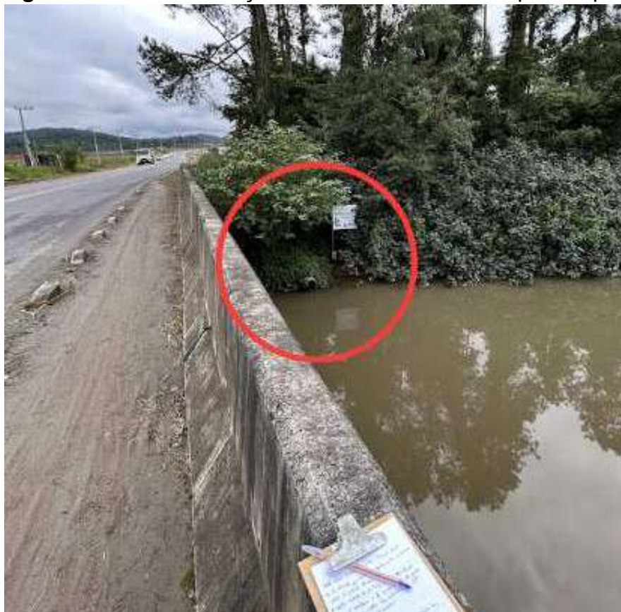
Figura 30 - Local de lançamento do efluente no corpo receptor
