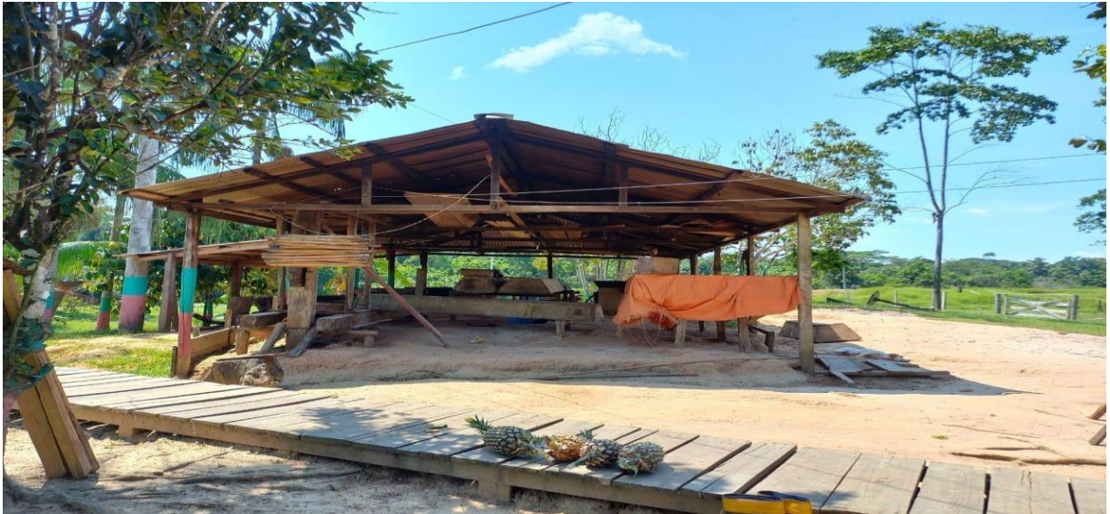
Figura 3. Casa de Farinha (Ramal de Igarapé Preto)
